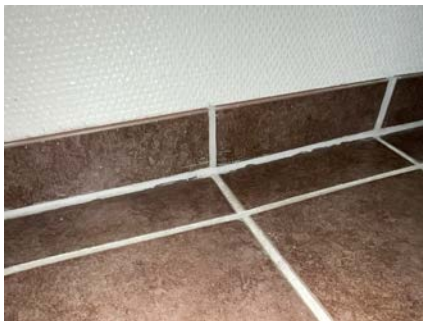
Avvik høydeforskjell fra gulv ved dør til sluk.
