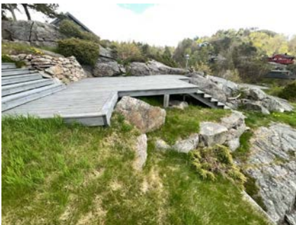
Manglende rekkverk
