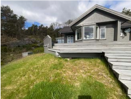
Manglende rekkverk
