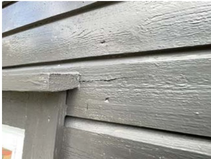
Enkelte sprekker i kledningen registrert.
