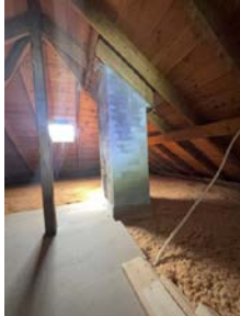
Takvindu - ikke gangbart gulv bort til vinduet. Etterisolert med innblåsing av løs isolasjon
