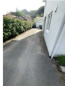
Flatt terreng rundt bygningen
