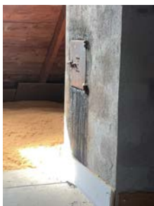
Rennemerker/sotvann under feieluke - loft
