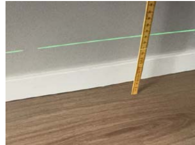
Høydeforskjell i stue/kjøkken - 1.etasje
