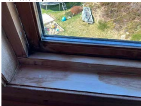
Kjellervindu i boden er punktert.
