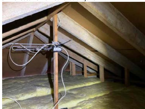
Loft over stua, her er sperrer og undertaket synlig.
