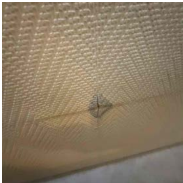
Belegg er klemt i sluket.
