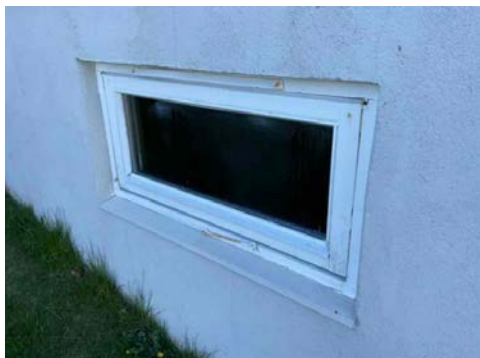
Kjellervindu i boden er punktert.
