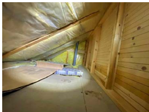
Taket er i hovedsak en lukket konstruksjonen.
