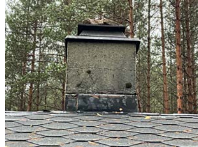
Utettheter rundt pipen.
