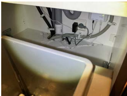
Lekkasjesikring montert under vasken
