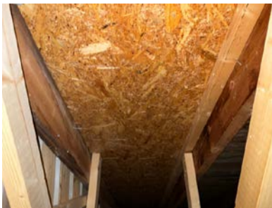
Nye deler med plater som undertak.
