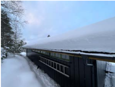
Hele taket er dekket av snø
