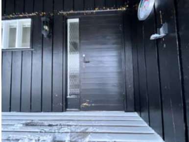
Utett mellom karm og ramme.
