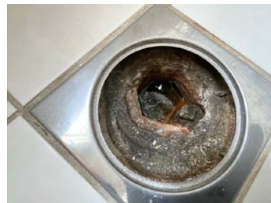
Eldre sluk uten synlig membran.
