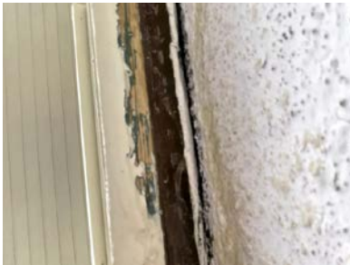
Lite lufting bak deler av kledningen på bygget.
