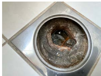
Eldre sluk uten synlig membran.
