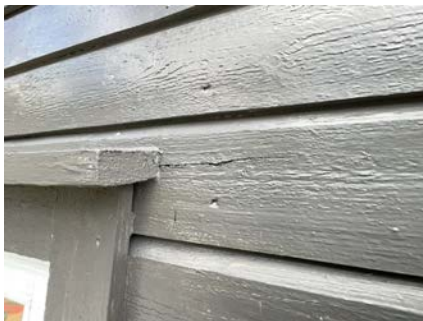
Enkelte sprekker i kledningen registrert.
