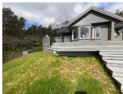
Manglende rekkverk
