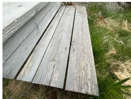
Noe slitasje registrert på overflater.
