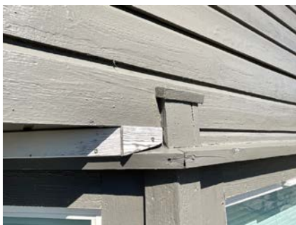
Enkelte sprekker i kledningen registrert.
