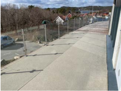
Rekkverk ca 90cm.
