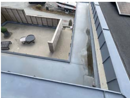
Taktekking av Sanafil.
