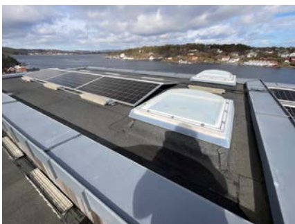
Taktekking av tjærepapp.
