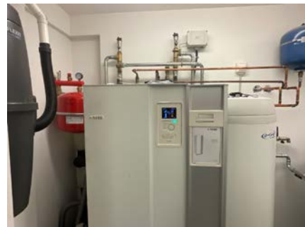
Rørføring for vannbårenvarme til bolig og basseng.
