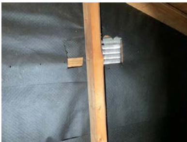
Lufting sammen med gavlveggene.
