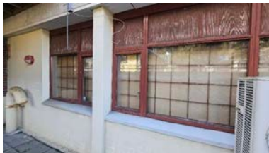
Fasade på baksida med slitte plater i tre.
