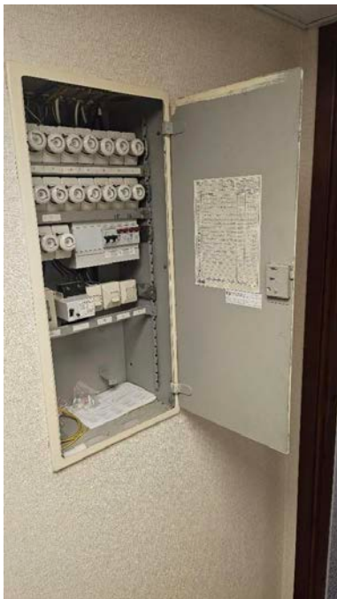
Sikkeringskap i kjeller.
