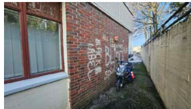
Fasade på baksida med betong og teglstein.
