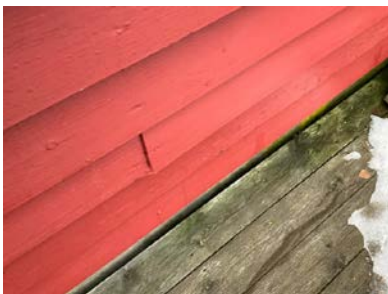
Kledningen er montert helt i mot plattingen.
