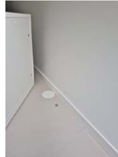
Det er montert et blendelukk over det største hullet.
