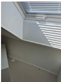
Bilde viser huller i gulv etter at gamle rør er fjernet.
