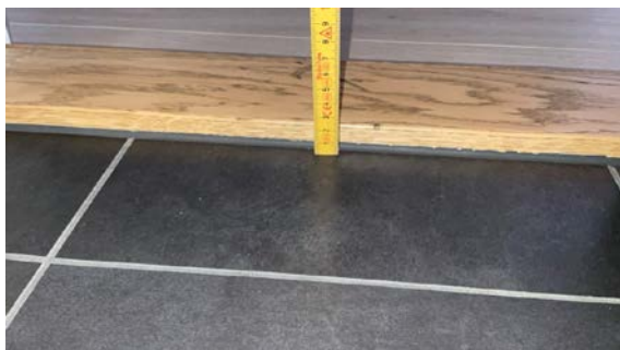
Utakstrek på laser er 11 cm på målestokk, bilde viser ca. 2 mm høydeforskjell fra overkant slukrist til gulv ved dørsvill.
