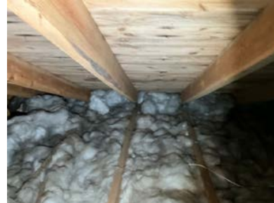
Isolasjon opp mot undertaket.
