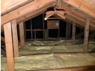
Lufting sammen med ytterveggene.
