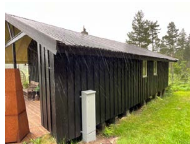
Undertak fra byggeår.
