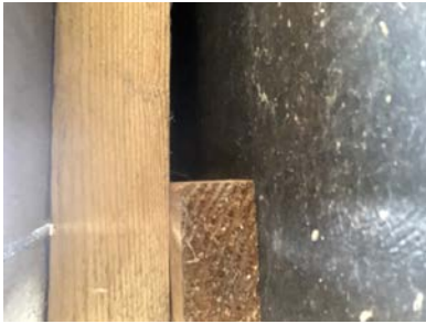
Eier har montert stålull etter befaringen.
