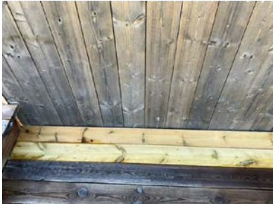
Kledning montert med gripe mot terrassen.
