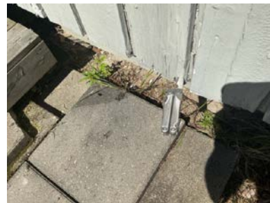
Råteskadet kledning.
