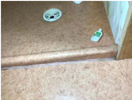
oppkant inn til sluk i dusj
