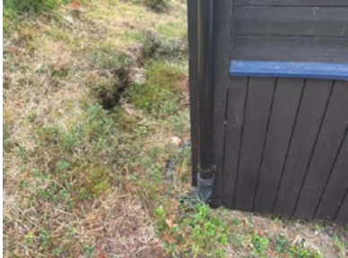
Nedløp ført ned i drensrør.
