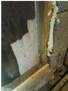
Glippe mellom dør og karm på kjellerdør
