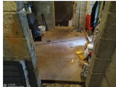
Løst tilfarergulv i kjellerinngang.
