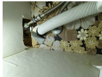
Utett løsning rundt avløpsrør
