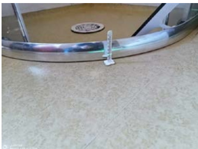
Måling fra dør mot dusjvegger
