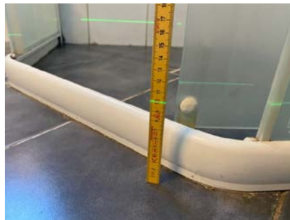
På utsiden av dusj, sokkel stenger for lekkasjevann.
