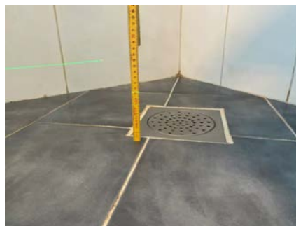
På utsiden av dusj, sokkel stenger for lekkasjevann.
