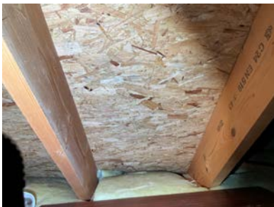
Isolasjon helt opp mot platene.
