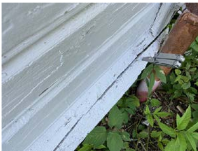
Råteskadet bunnstokk.
