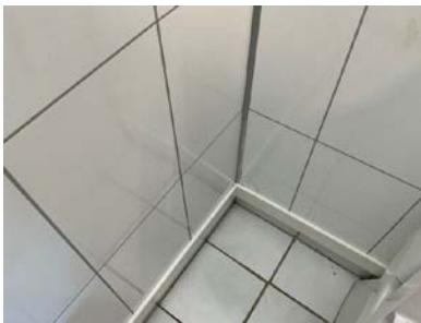
Trelist i overgangen mellom plater og fliser.
