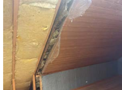
Overgang eldre del av bolig/tilbygg.
