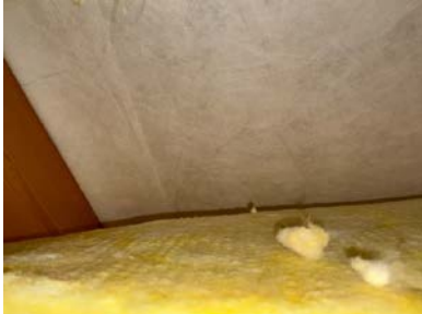
Diffusjonsåpen duk på tilbygg.
