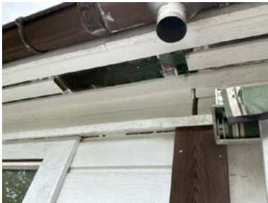
Nedløp uten utkast på taktekking.
