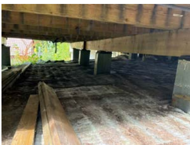
Underside av terrasse.
