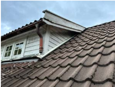
Nedløp uten utkast på taktekking.
