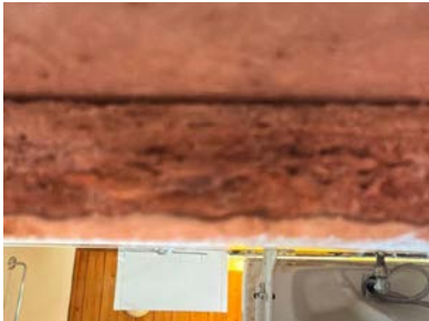
Fuktskade i nedre del av våtromplater.
