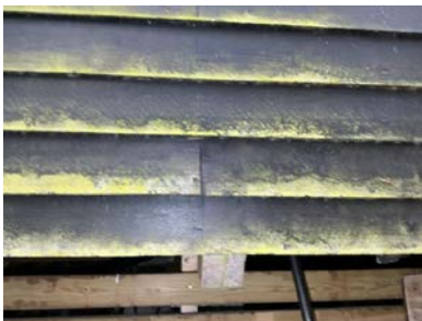
Hull opp i luftingen, tilgang for skadedyr.
