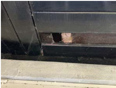
Hull opp i luftingen, tilgang for skadedyr.
