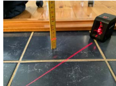
Mangler oppkant ved dør.
