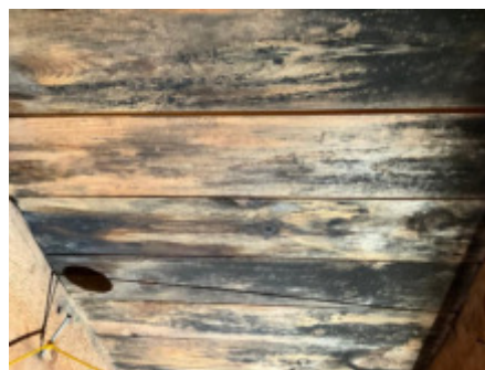
Svakt forhøyet fukt er målt i undertaket.
