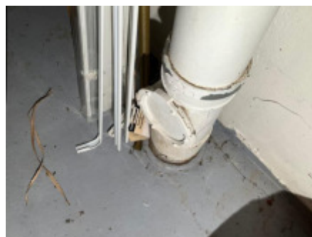
Stakeluke i kjelleren.
