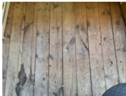
Spor etter treborende insekter i gulvet på loftet.
