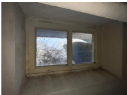
Vinduer med enkle glass i kjelleren.
