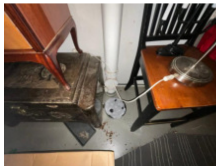
Stakeluke i kjelleren.
