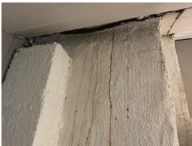
Rennemerker på pipe v/tak.
