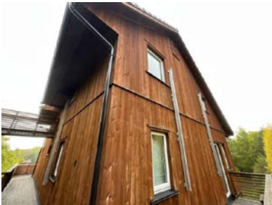
Luke for inspeksjon på gavlveggen.
