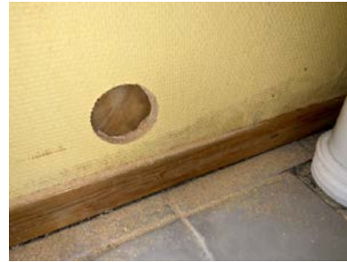
Plast på innsiden av veggene.
