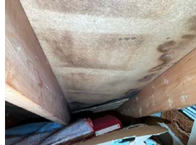
Fuktmerker, holdes videre under oppsikt.
